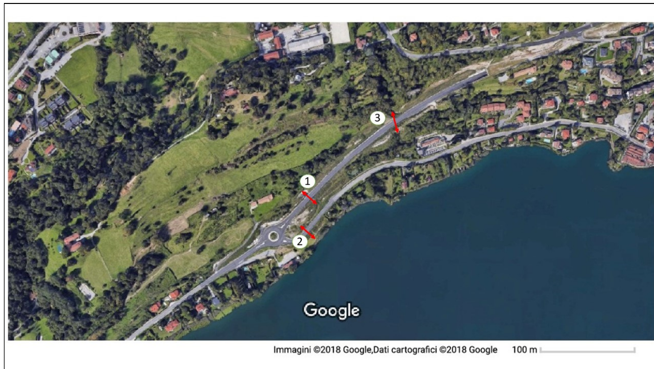
Figura 4 – Localizzazione dei tunnel nel settore ovest della variante alla ex S.S. 639 (vista di insieme).
