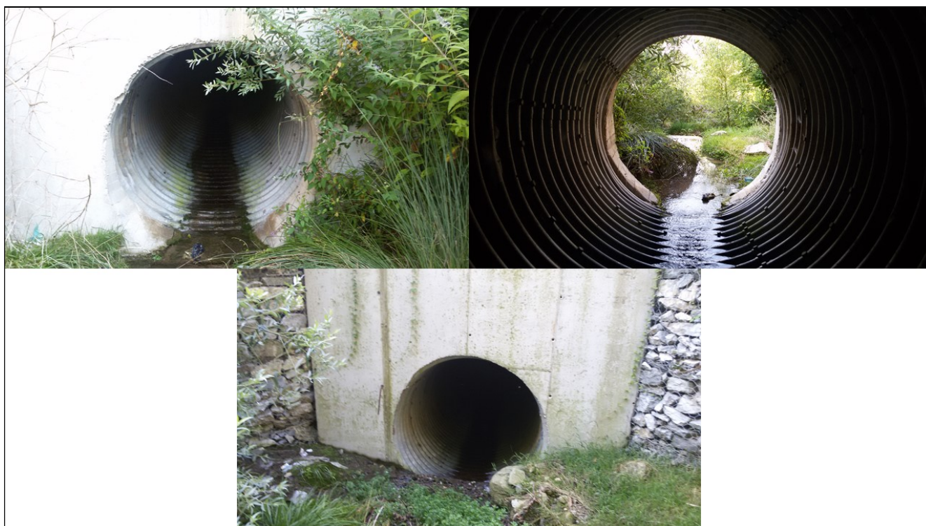
Figura 11 – Il tunnel n.3 (ingresso sud, l'interno e l'ingresso nord)
